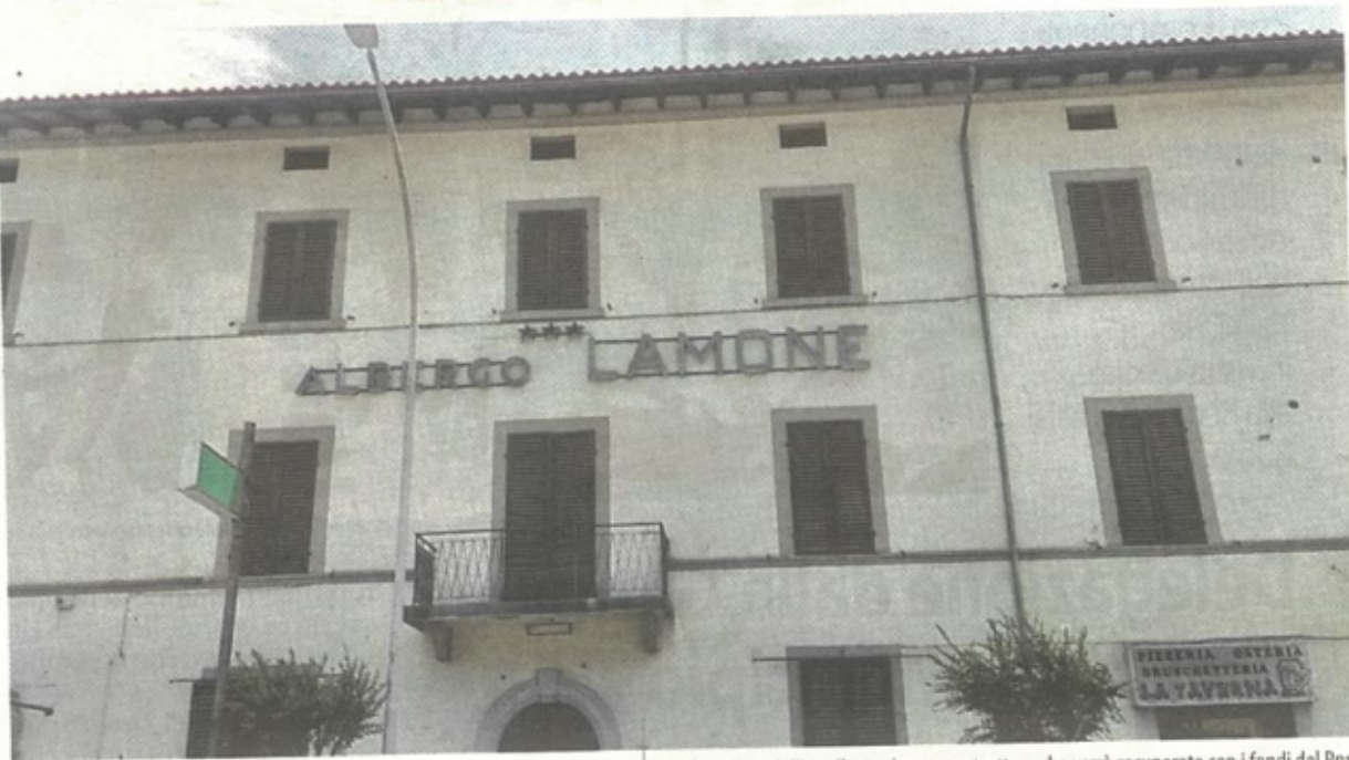
La facciata dell'ex albergo Lamone, struttura che verrà recuperata con i fondi del Pnrr
